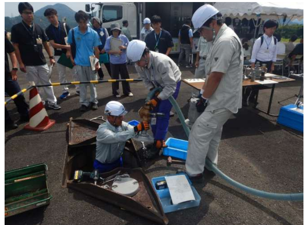
研修の様子（空気弁の分解組立てと応援給水装置設置の実演）
