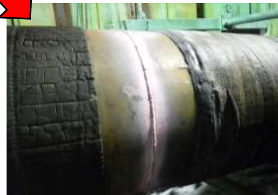
配水管交換・溶接完了
