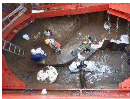
漏水箇所復旧作業
