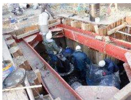
不断水工法による仮設管分岐作業
