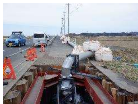
仮設管設置状況
