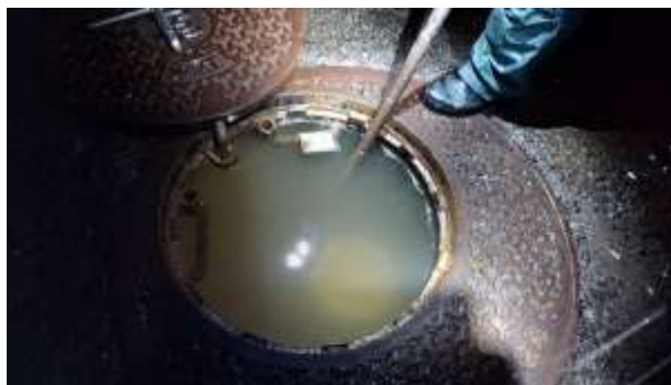
空気弁応急復旧（副弁を閉止）
