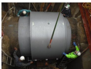
補強工事の一例(カバージョイントの追加)
