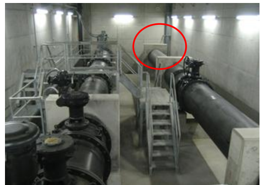
馬越石水力発電所 発電設備設置予定箇所
