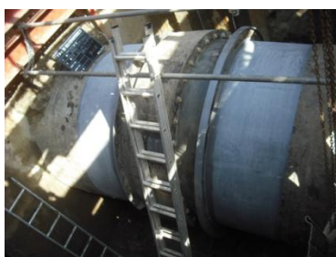
補強工事の一例(カバージョイントの追加)
