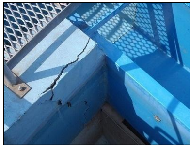
(左)工業用水の7ヶ所部鋼材亀裂と(右)仙南・仙塩広域水道浄水場内損壊
