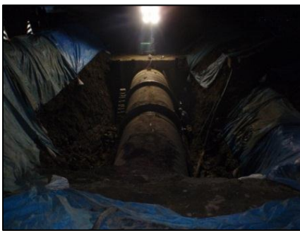
SPφ2,400の夜間漏水復旧作業
