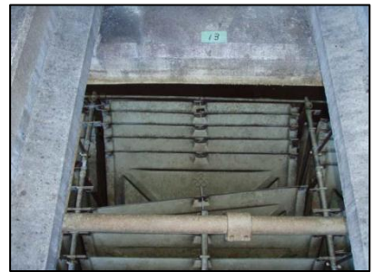
(左)工業用水の7ヶ所部鋼材亀裂と(右)仙南・仙塩広域水道浄水場内損壊
