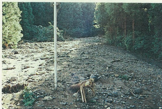
▲名取市高館川上地内／県道名取一村田線の土砂に埋った道路
