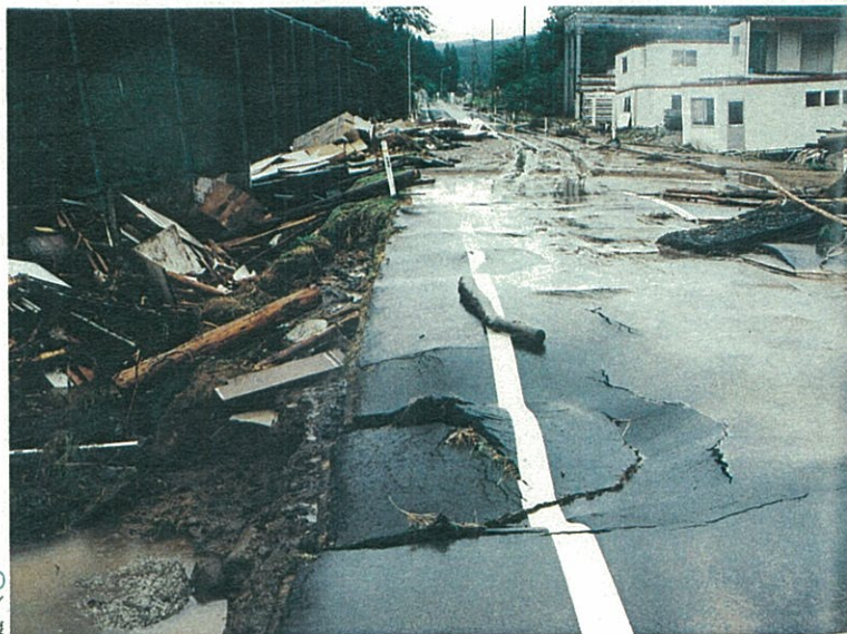
17 岩沼市志賀字石山／ 鉄砲水で道路も破壊
