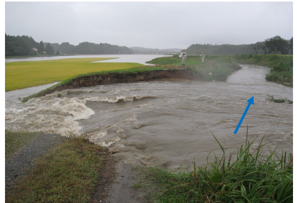
図－8 堤防決壊状況
