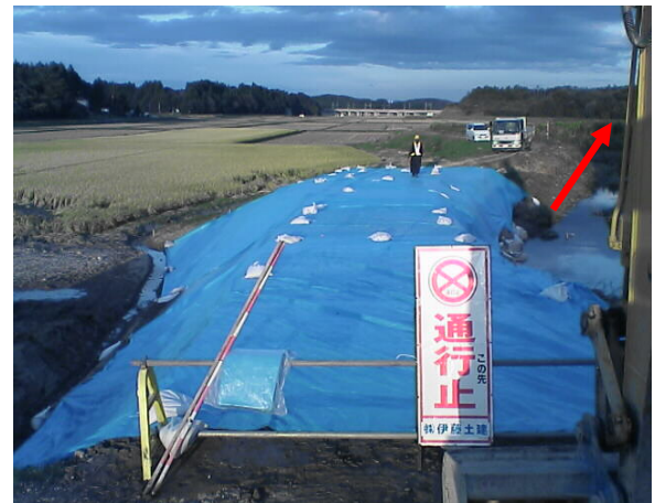
復旧完了状況
