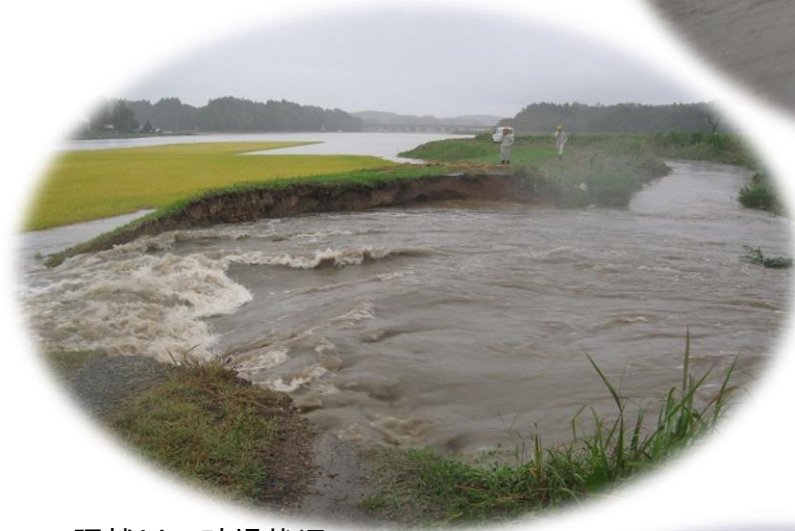
照越川の破堤状況 (栗原市築館照越)
