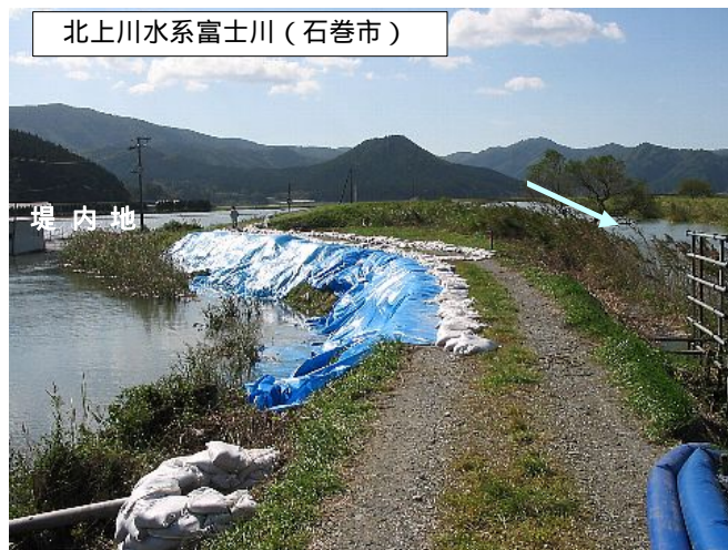
シート張工・月輪工法
