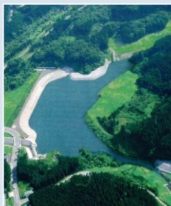
かみおおさわ 上大沢ダム (ダム本体のみ) ¥ 300,000~
