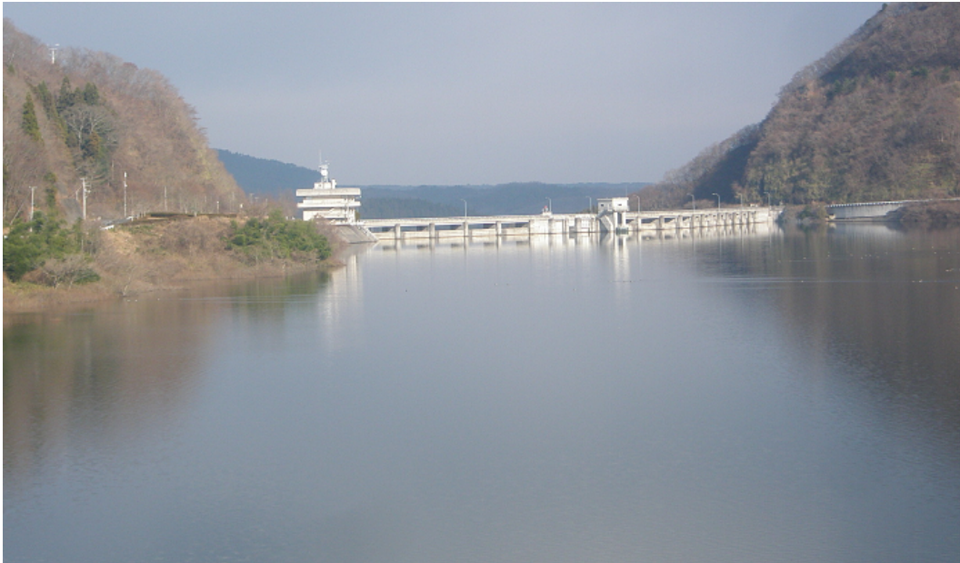
ダム湖の橋の橋より望む
