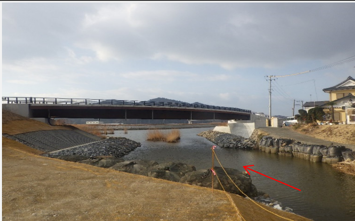
石崎橋の保護護岸工が完了しました。
