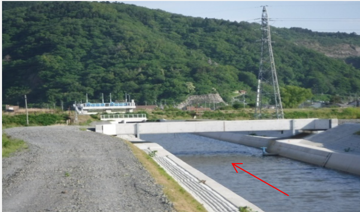
八津川の水門、橋梁、堤防が完成しました。
