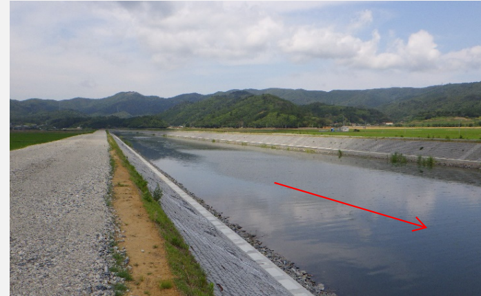
真野川の護岸が完成しました。
