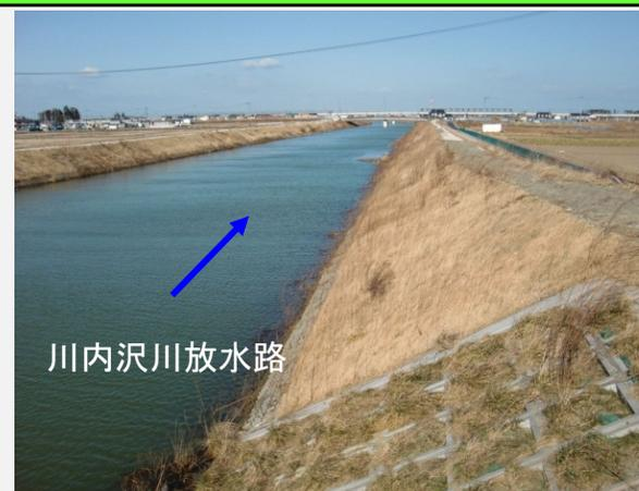
放水路の掘削・築堤工事が完成し通水しています。
