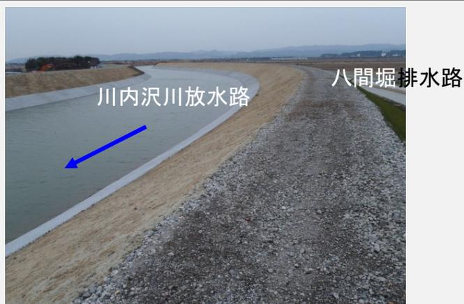
排水路付替えと放水路の掘削・築堤工事が完成し通水しています。
