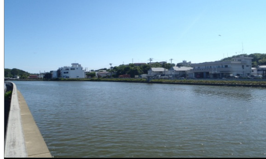
④ 着手前 平成25年4月
