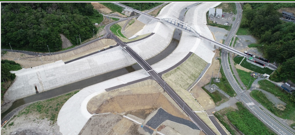
【工事施工箇所全景】
