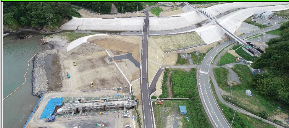
【工事施工箇所全景】
