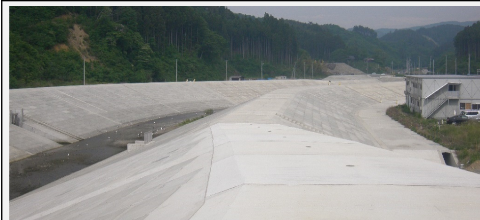
【築堤・護岸】JR気仙沼線より上流側全景
