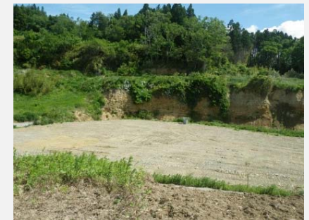
④ 着手前 平成27年5月
