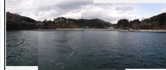
② 着手前 平成25年10月
