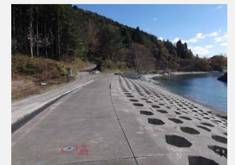
④ 着手前 平成25年10月
