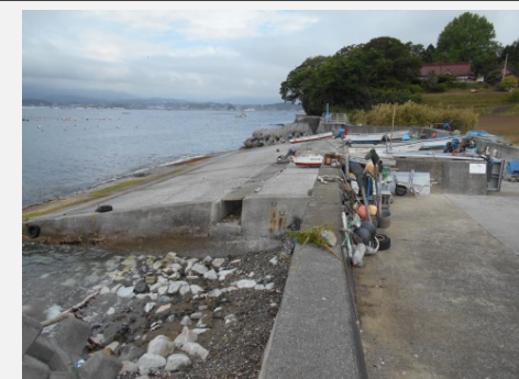
④ 着手前 平成29年6月
