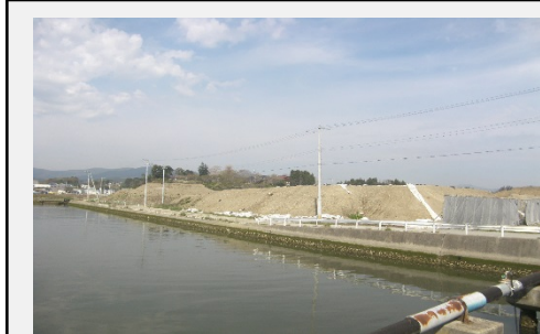
左岸側 着手前 平成26年12月
