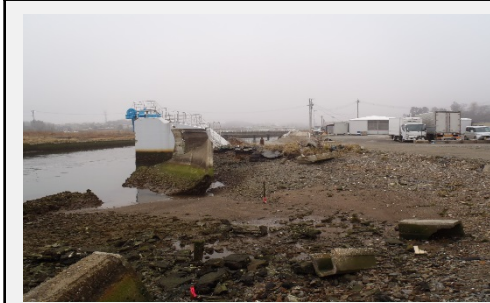
② 左岸側 着手前 平成26年12月
