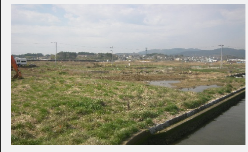
右岸側 着手前 平成26年12月
