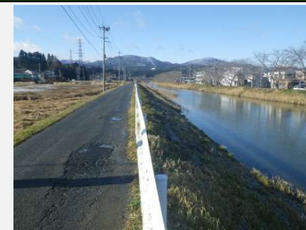
④ 着手前 平成26年12月
