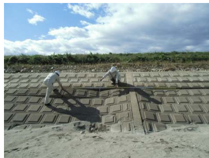
護岸の点検状況（七北田川）
