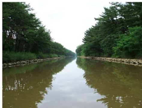
震災前の新堀（南貞山運河）
