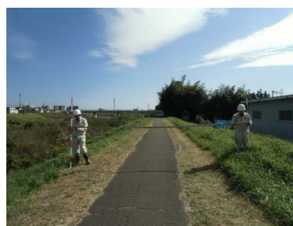
堤防の点検状況（七北田川）
