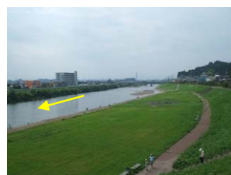
七北田川下流部 岩切大橋より上流を望む
