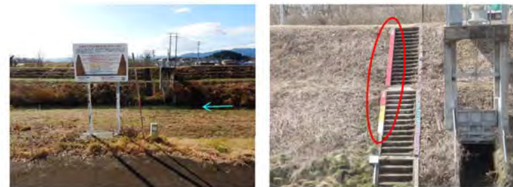
図 2-50 水位レベル表示板（小田川）
