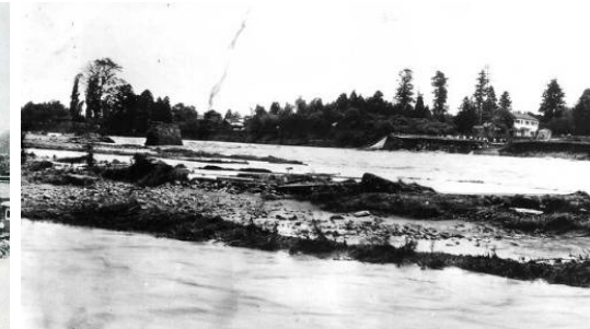
昭和25年8月洪水 (広瀬川宮沢橋流出)
