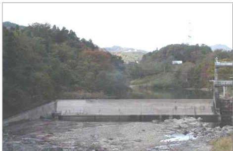
茂庭発電所取水堰（名取川）
