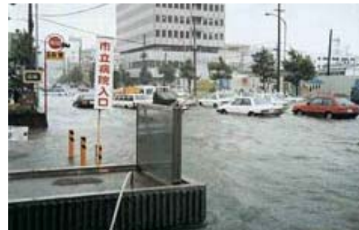
昭和61年8月洪水 (仙台市立病院の冠水)
