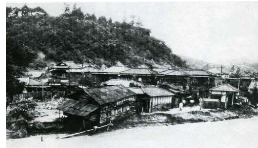
昭和28年8月洪水 (広瀬川愛宕橋上流)
