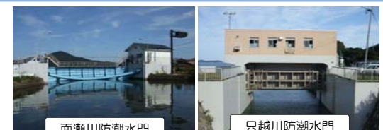
面瀬川防潮水門
