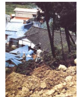
松島町のがけ崩れて4戸が被害
