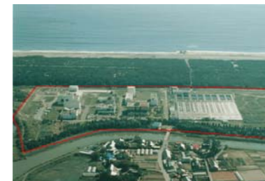
阿武隈川下流域下水道 県南浄化センター
