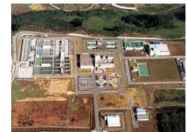
仙南・仙塩広域水道事務所
