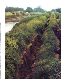
定川堤防の亀裂
