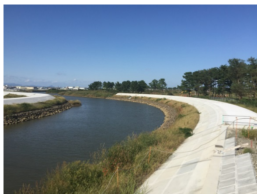
寄石・覆土状況
