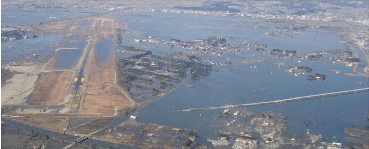
写真 空港の被害状況
