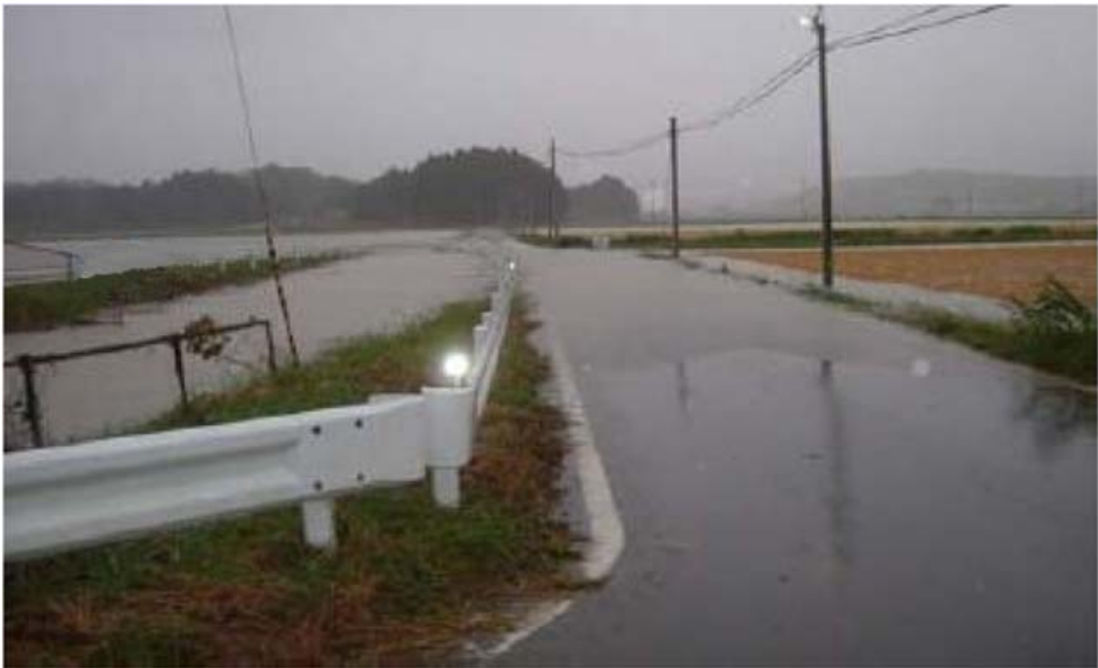
写真 1-2 平成 18 年 9 月洪水時の冠水状況（坂元川）
