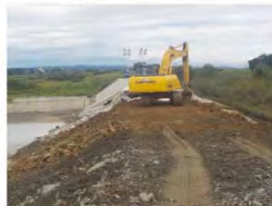
応急復旧状況
