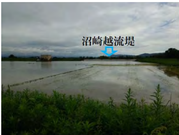
沼崎越流堤(越流状況11:58)
