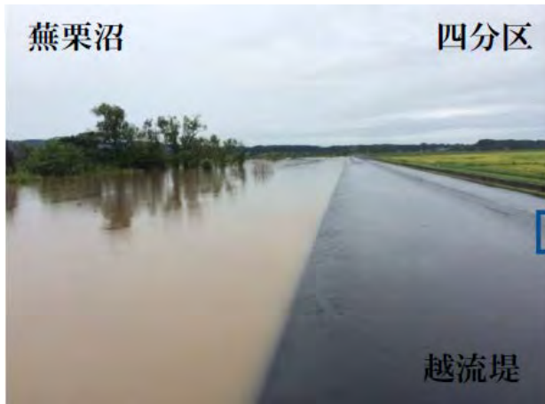
四分区越流堤(越流直前8:30)
