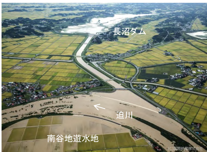
長沼ダム・南谷地遊水地の越流状況
