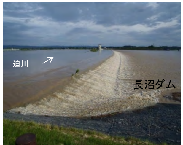
砂原越流堤(越流状況)
