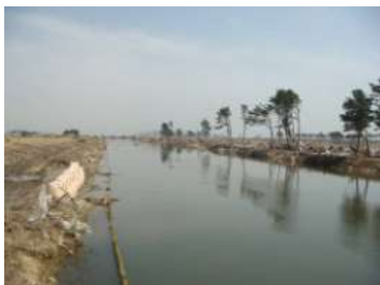
堤防の被災・流出（南貞山運河）
