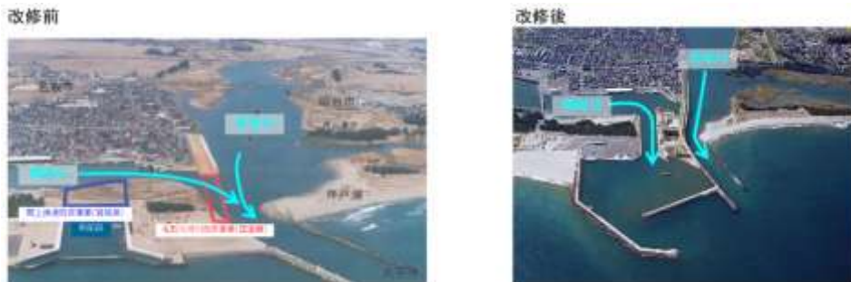
図 1-11 名取川河口部築堤工事（国土交通省）と閑上漁港整備事業（宮城県）
