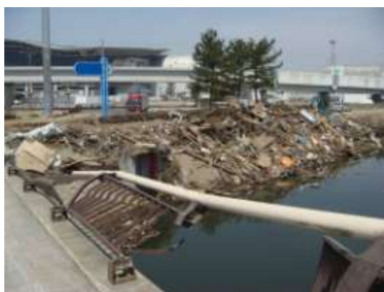
被災した橋梁（五間堀川）
