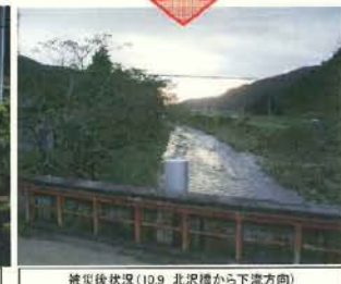
被災後状況(10.9 北沢橋から下流方向)
