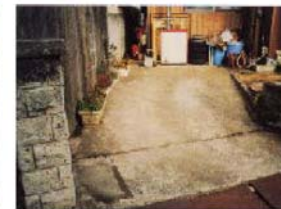
■ 空隙貯留（石油化学製品）
