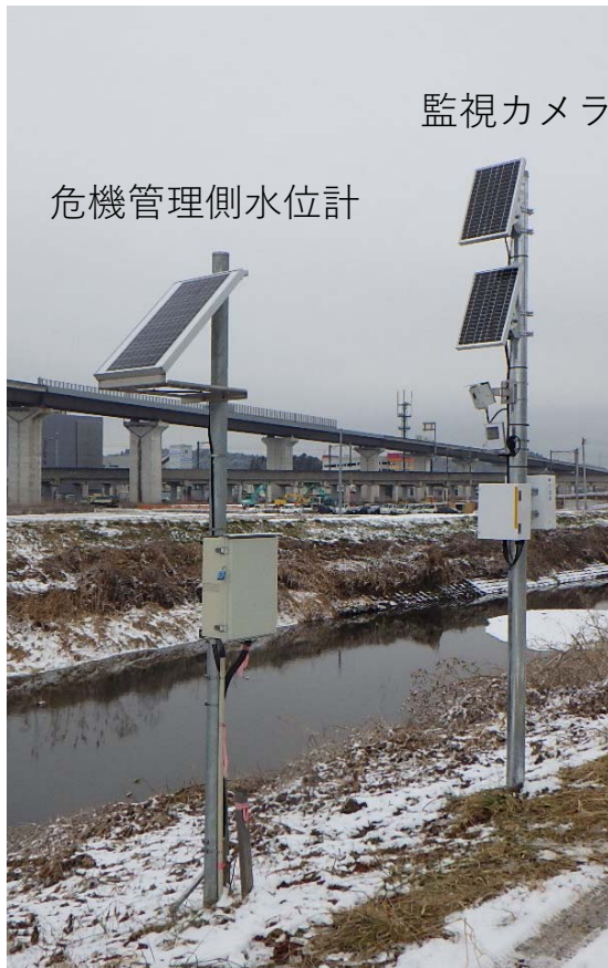
監視カメラ 設置状況（砂押川）
