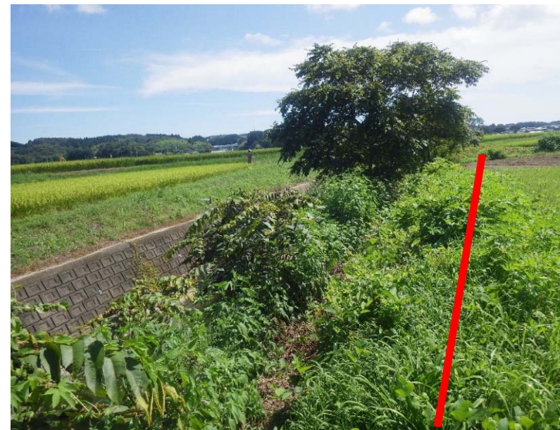
勿来川（多賀城市市川地内）
