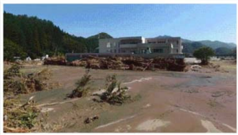
平成28年台風第10号による被害状況
