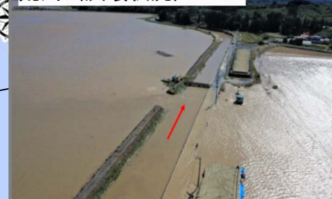
砂押川（決壊状況）
