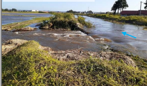
渋井川（決壊状況）
