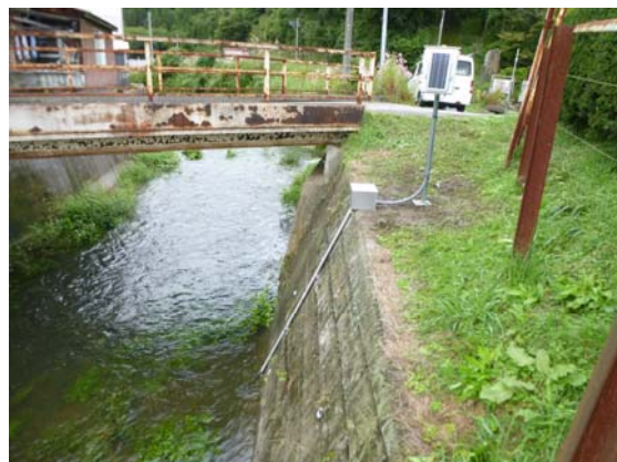
図：危機管理型水位計設置状況(松川)
