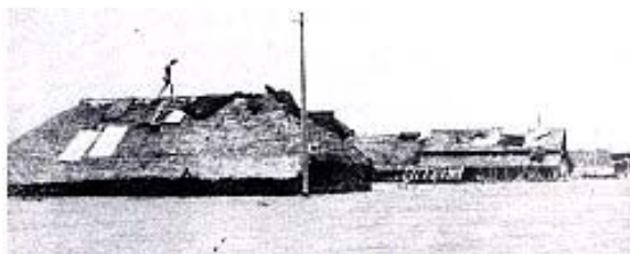
洪水被害状況
