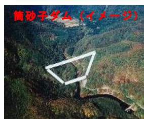
筒砂子ダム (イメージ) 宮城県 (建設中)
