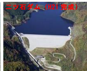
二ツ石ダム (H21 完成) 農林水産省 (供用中)
