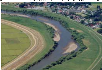
写真 2-32 鳴瀬川の水際の状況
