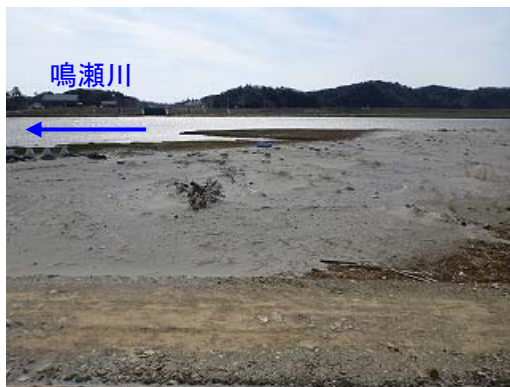
写真 2-37 河口部左岸高水敷の状況
