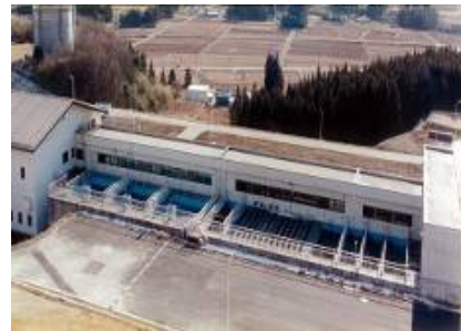
写真 2-9 なかみね 中峰浄水場
