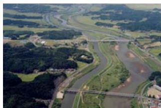
写真 2-28 背割堤の状況
