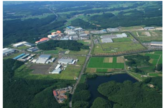
写真 2-10 仙台北部工業団地
