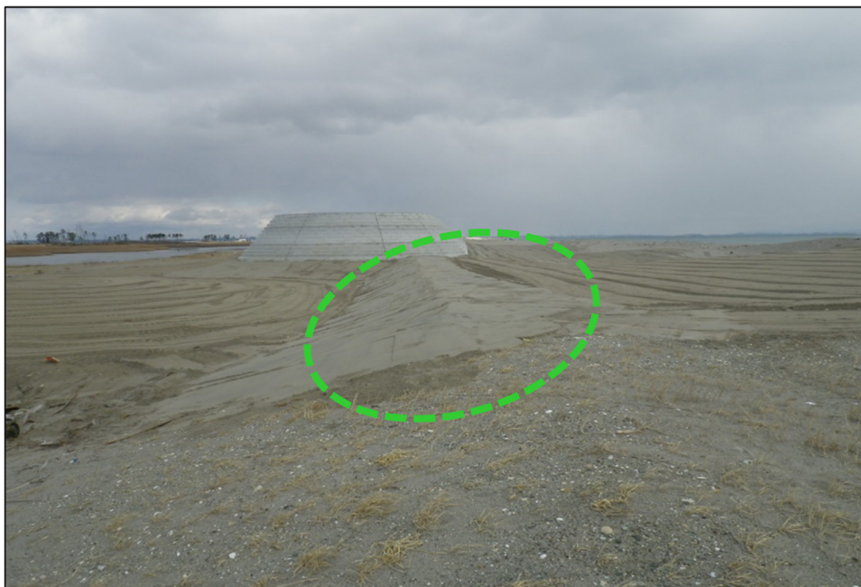
写真 4-21-4 造成した砂州【閑上漁港海岸】
