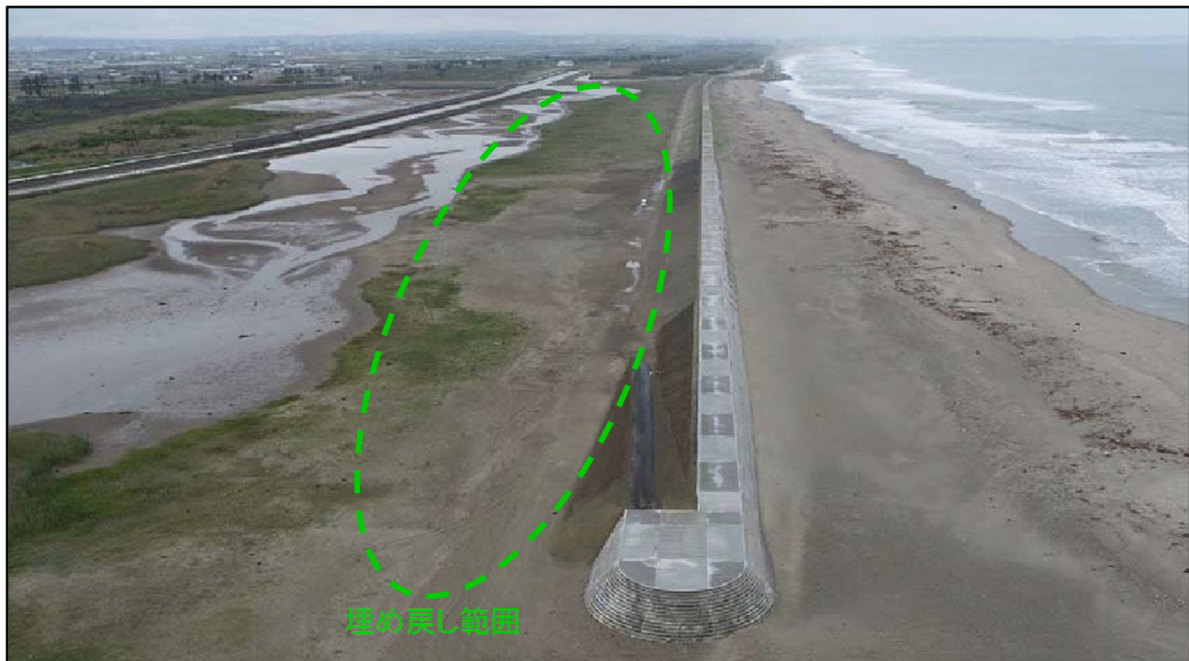
写真 4-21-3 工事後の埋戻し状況 【閑上漁港海岸】
