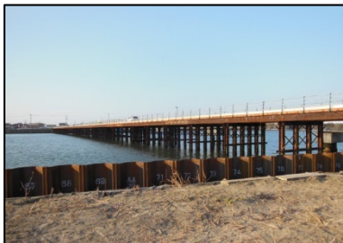
防潮護岸工・仮棧橋工確認箇所
