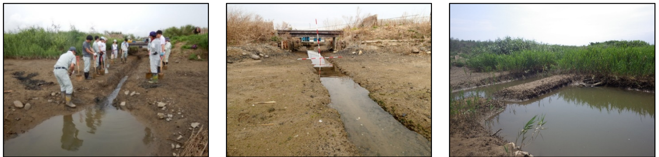
湿地水路内掘削作業状況
