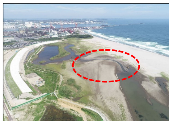
滞筋掘削後状況
