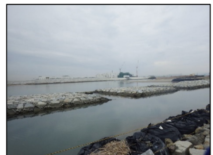
切欠き部の状況
