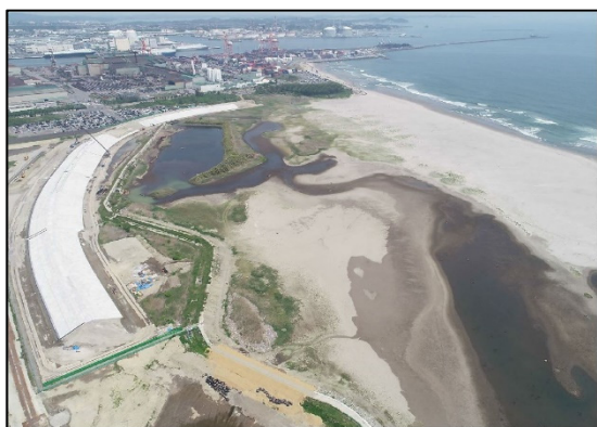
滞筋掘削前状況
