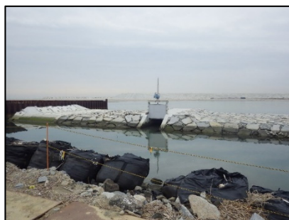
樋管部の状況
