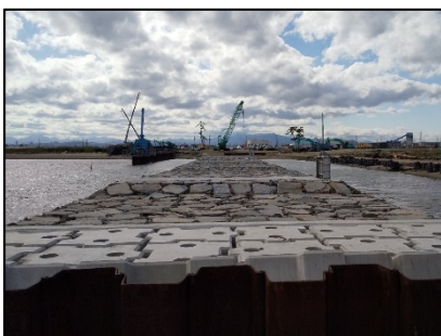
通水部天端の状況
