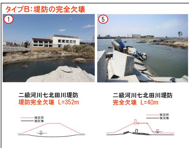
図 4-16-3 堤防被災状況【七北田川（蒲生）】
