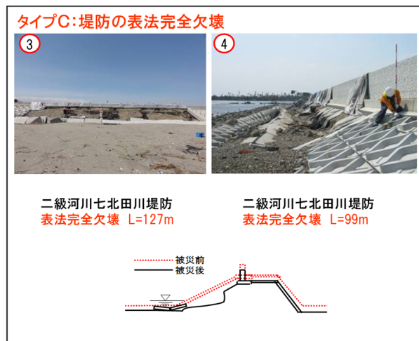
図 4-16-3 堤防被災状況【七北田川（蒲生）】
