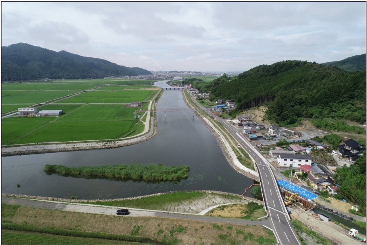
真野川（中間部）の状況（令和2年7月27日）
