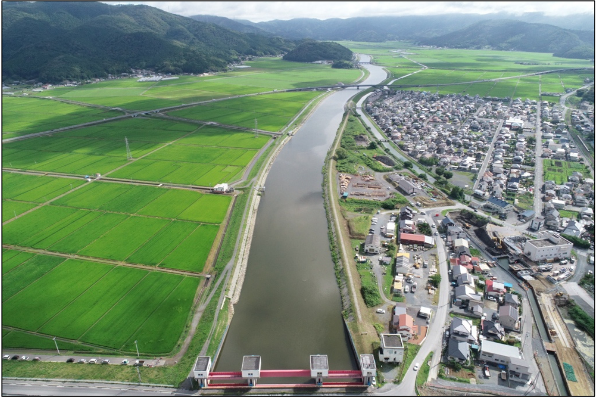
真野川（旧北上川側）の状況（令和2年7月27日）
