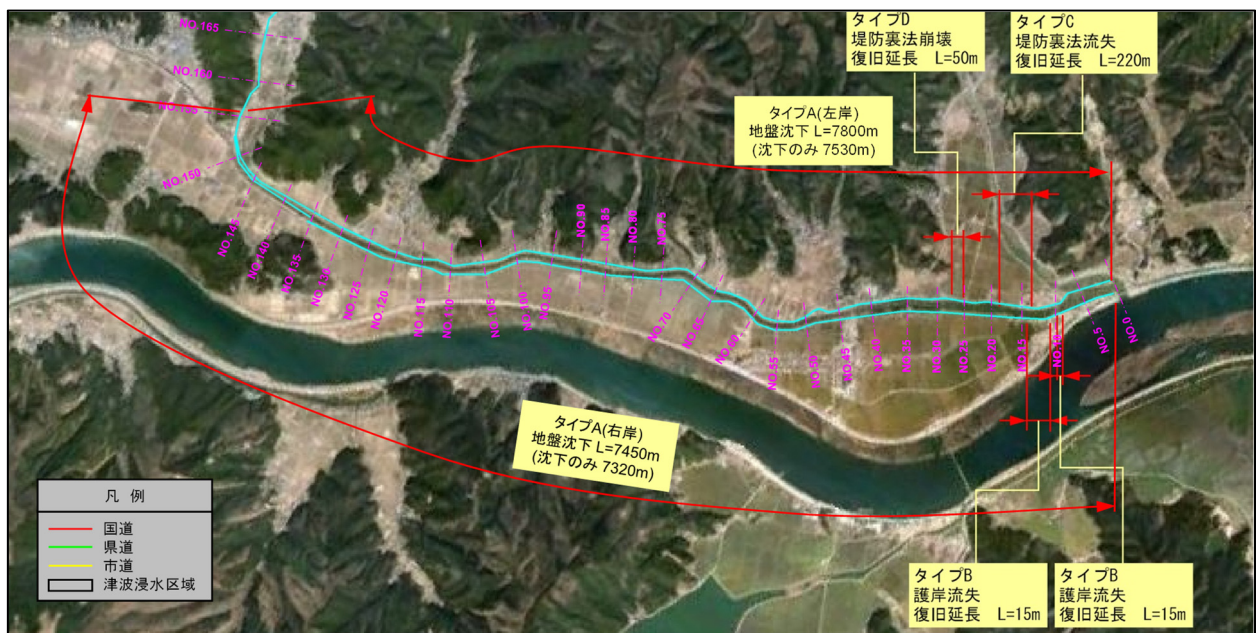
図 4-8-4 皿貝川被災状況【大沢川外 4 河川】
