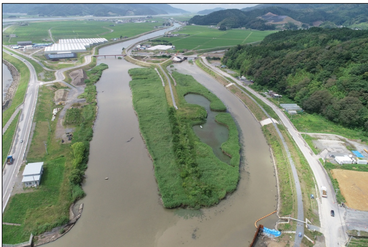
写真 4-8-7 大沢川・皿貝川合流地点（背割堤）の状況（令和 2 年 7 月 22 日）【大沢川外 4 河川】
