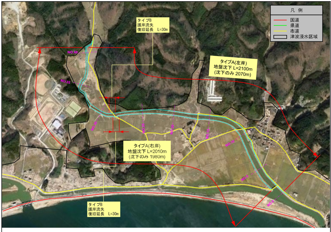
図 4-8-5 追波沢川被災状況【大沢川外 4 河川】
