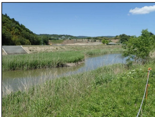
写真 4-8-6 背割堤非改変区域の状況（令和2年5月）【大沢川外4河川】
