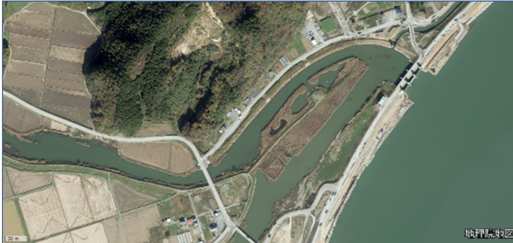
写真 4-8-4 震災後の背割堤の状況（平成 25 年 9 月）【大沢川外 4 河川】
