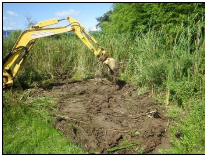
移植先整地作業状況
