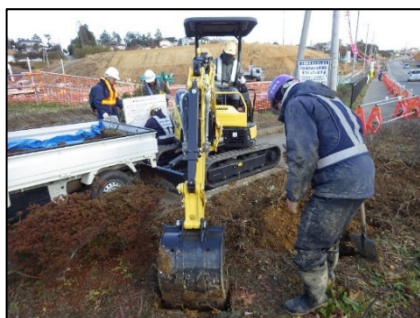
掘取り作業状況
