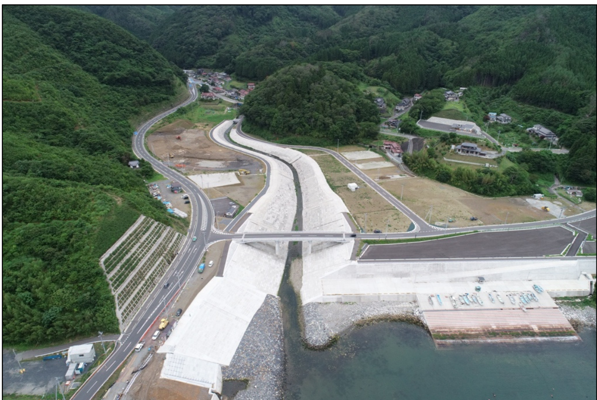
写真4-1-8 只越川の状況(令和2年7月27日)【只越川】
