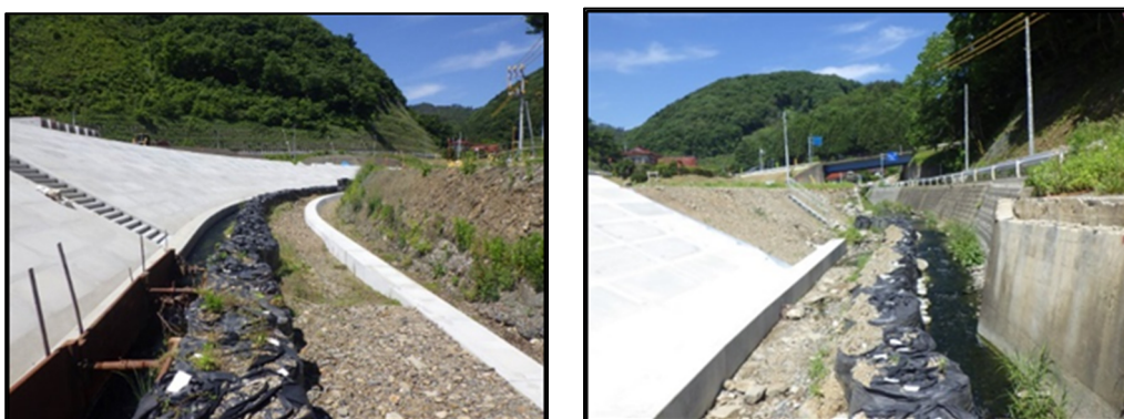
写真 4-1-3 瀬替えの状況【只越川】
