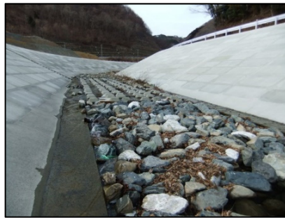
洗掘箇所補修後の状況 (令和2年2月10日撮影)
