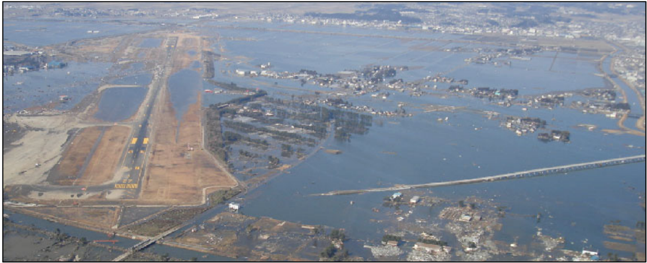
写真 1- 5 仙台空港の被害状況
