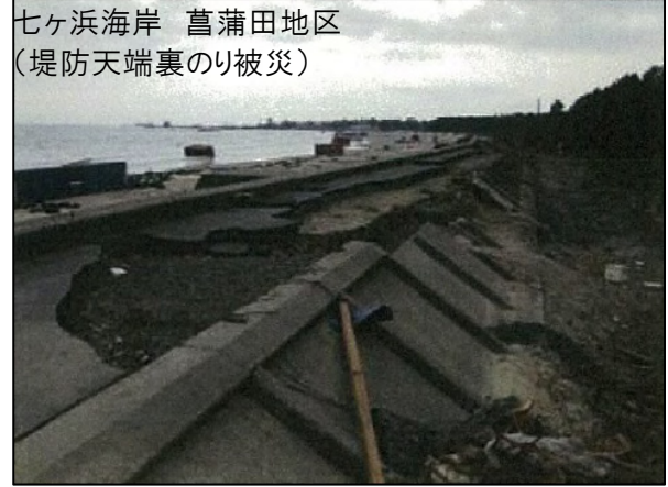
写真 1-1 海岸堤防の被害状況
