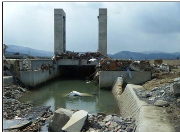
写真 1-2 河川堤防の被害状況
