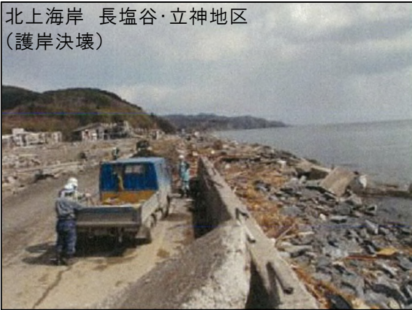
写真 1-1 海岸堤防の被害状況
