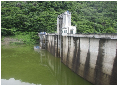
貯水池 ダム堤体上流 (撮影:7月11日9時40分)
