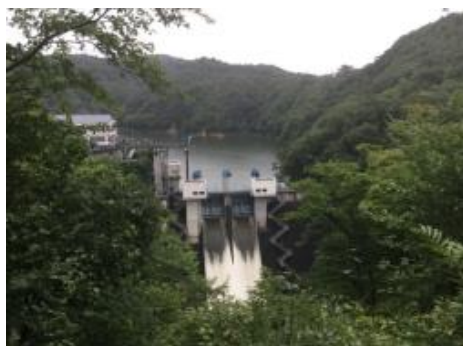
花山ダム 放流状況 (撮影:8月9日5時)
