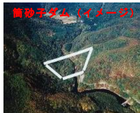
宮城県（建設中）
