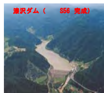
宮城県(土木)施工
