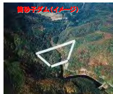
宮城県(土木)施工
