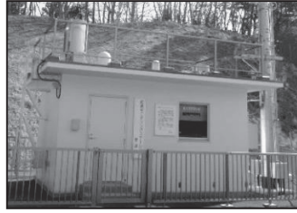
周辺モニタリングステーション （再建局）
